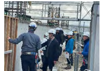
自社現場を活用した 国産材のトライアル
