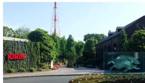
麒麟ビール横浜工場
