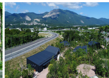
にぎわいの森 (三重県いなべ市)
